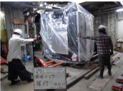
搬入設置工事
